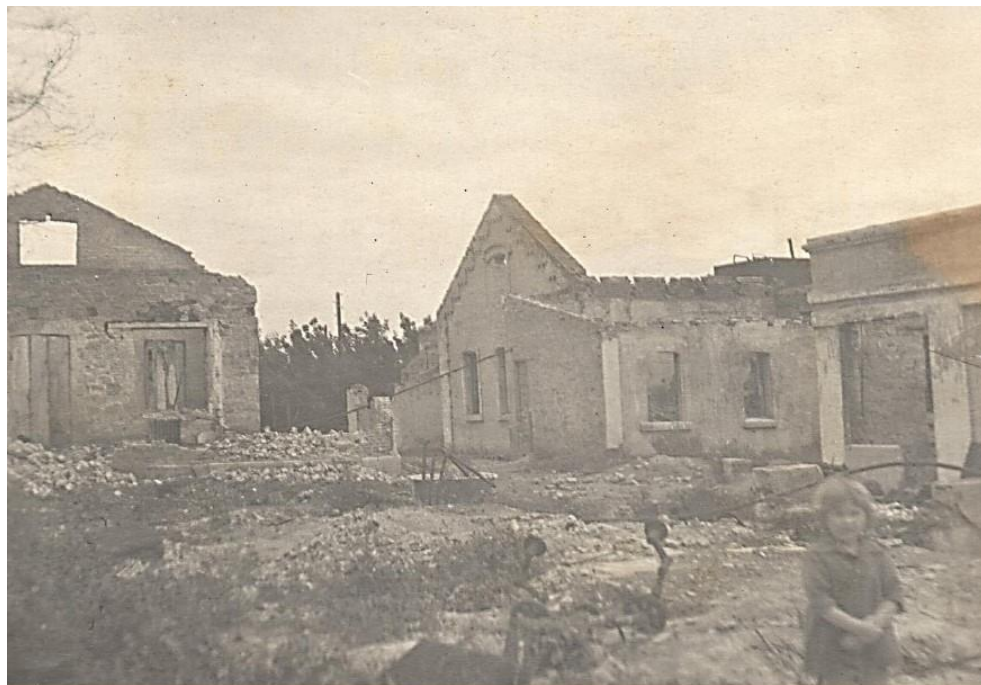
Разрушенные частные жилые дома в Сталино-заводском районе, г. Сталино, 1943 г. Фото ГА ДНР. Ф. Ф. Оп. 20. Инв. № 113
